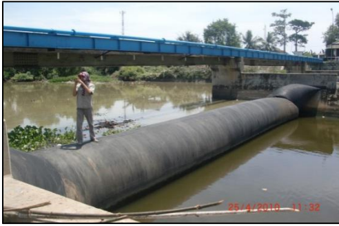
Gambar 12. Pendangkalan Di depan Tubuh Bendung (Upstream) Mengarah Ke Laut (Lokasi Bendung Karet Cibanten, Serang Banten)
