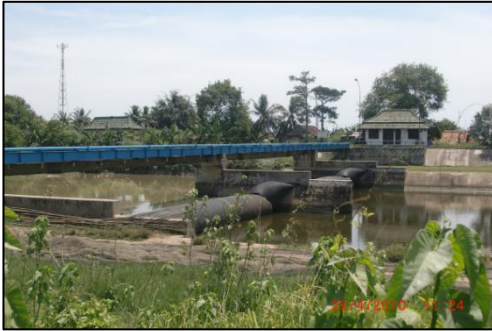
Gambar 13. Tampak Bendung Karet Cibanten, Serang Banten
