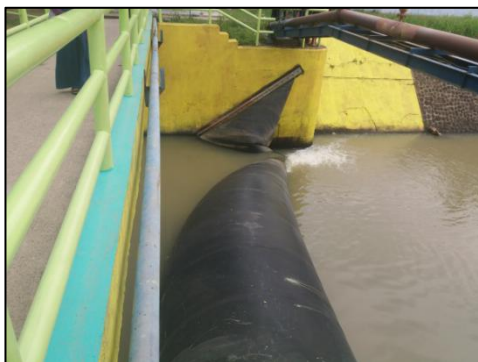
Gambar 15. Kerusakan Pada Tubuh Bendung Karet Karena Di Sobek (Lokasi bendung karet Cisirih, desa kamasan kec.Cinangka, Serang Banten)
