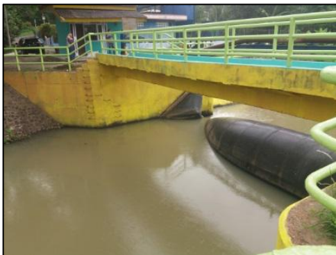
Gambar 14. Kerusakan Pada Tubuh Bendung Karet Karena Di Sobek (Lokasi bendung karet Cisirih, desa kamasan, kec.Cinangka Serang Banten)
